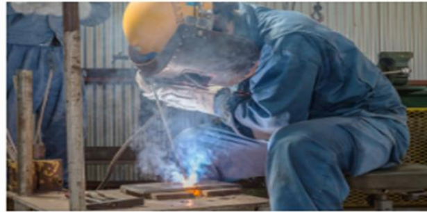
手溶接（アーク溶接）
