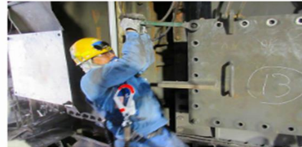
稼動設備の開放点検
