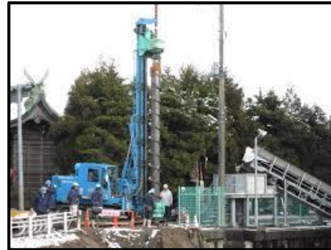
実際の杭を打ち込み作 業の風景
