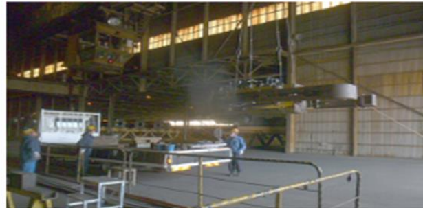
クレーン部品交換・積込作業
